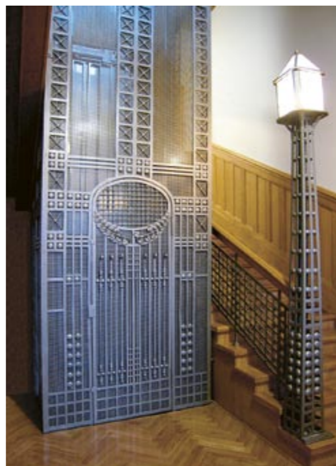
53. att. Līfīta šahtas metālkaluma režģis un izsmalcinātās kāpņu margas veidotas jūgendstila ģeometriski ornamentālo rotājumu izteiksmē
