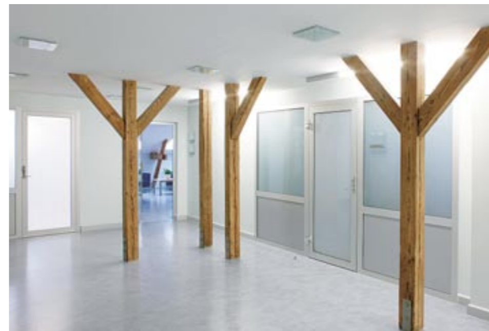
50. att. Bēniņos, izbūvējot ēkas piekto stāvu, saglabātas oriģinālās koka sijas un balsti. Izveidotas mazas un kompakts biroja telpas
